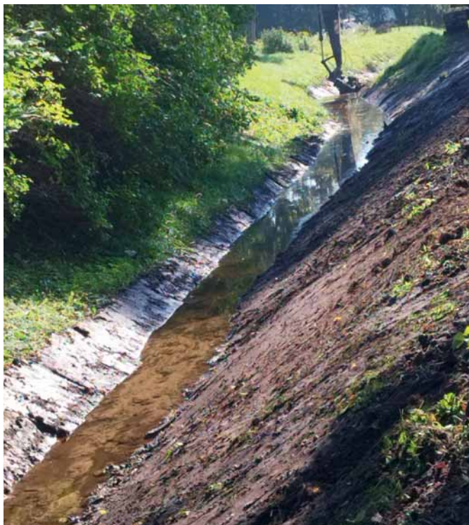
Pārtīrītā Zemgales ielas grāvja gultne Aucē
