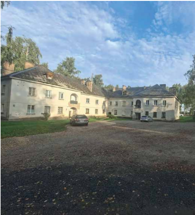
Labiekārtotais iekšpagalms Bērzes ielā 28, Dobeļē
