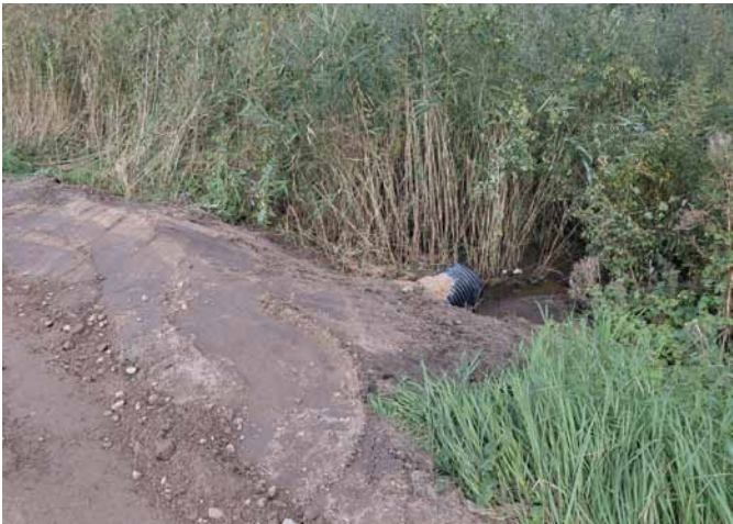
Caurtekas izbūves darbu gaita Penkulē, autoceļš Nr. PE 8416 “Ceļmalas–Bituļi” 0,38.-0,400. km
