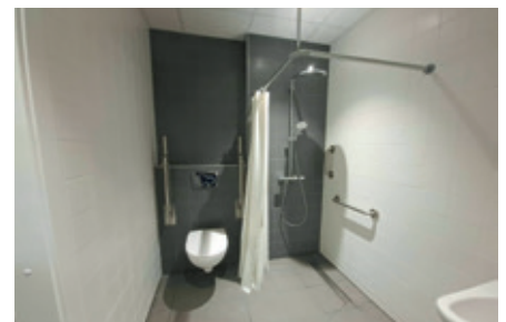
Atjaunotā paaugstināta komforta palāta un sanitārais mezgls
