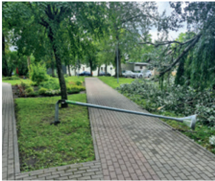
Vētras laikā nolauzts parka apgaismojuma balsts Dobelē
