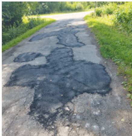
Asfaltbetona seguma bedrīšu remonts Vecaucē, autoceļš Nr. VE01 "P96-Irbēni-V1119"
