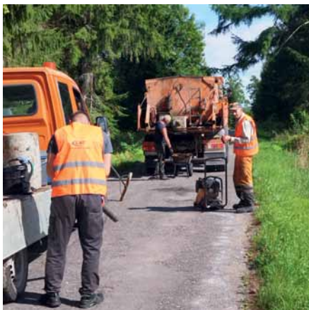
Asfaltbetona seguma bedrīšu remonts Vecaucē – autoceļš Nr. VE01 P96–Irbēni–V1119
