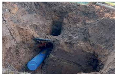
Lietus kanalizācijas un dīķa ūdens novadsistēmas sakārtošanas darbi Austrumu ielā 18, Dobelē
