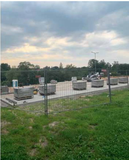
Stāvlaukuma izbūve pie daudzdzīvokļu mājas Krasta ielā 9
