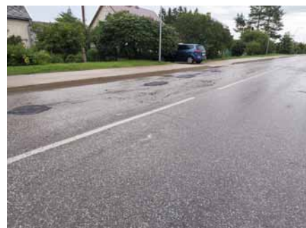
Asfaltbetona seguma bedrīšu remonts Dobelē
