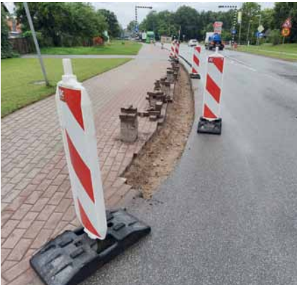
Brīvības ielas posma būvdarbi Dobelē – bojāto ielas apmaļu nomaīņa
