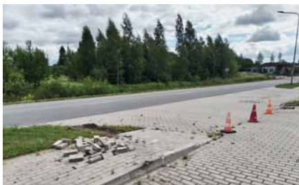
Brūgakmens seguma remontdarbu zona Spodrības ielas galā, Dobelē
