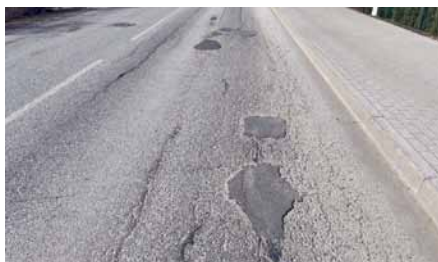
Bedru remonts Dobeles pilsētā ar auksto bitumaksu.
