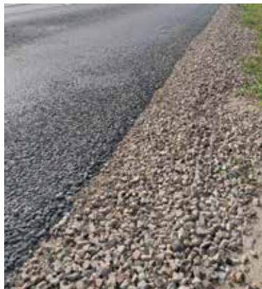
Nomaļu piebēršana un iesēdumu remonts Lauku ielā, Dobelē.
