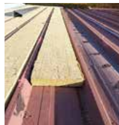
Pirmās kārtas 50 mm akmens vates ieklāšana.
