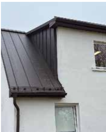
Nomainītais Bikstu pamatskolas palīgēkas jumta segums.
