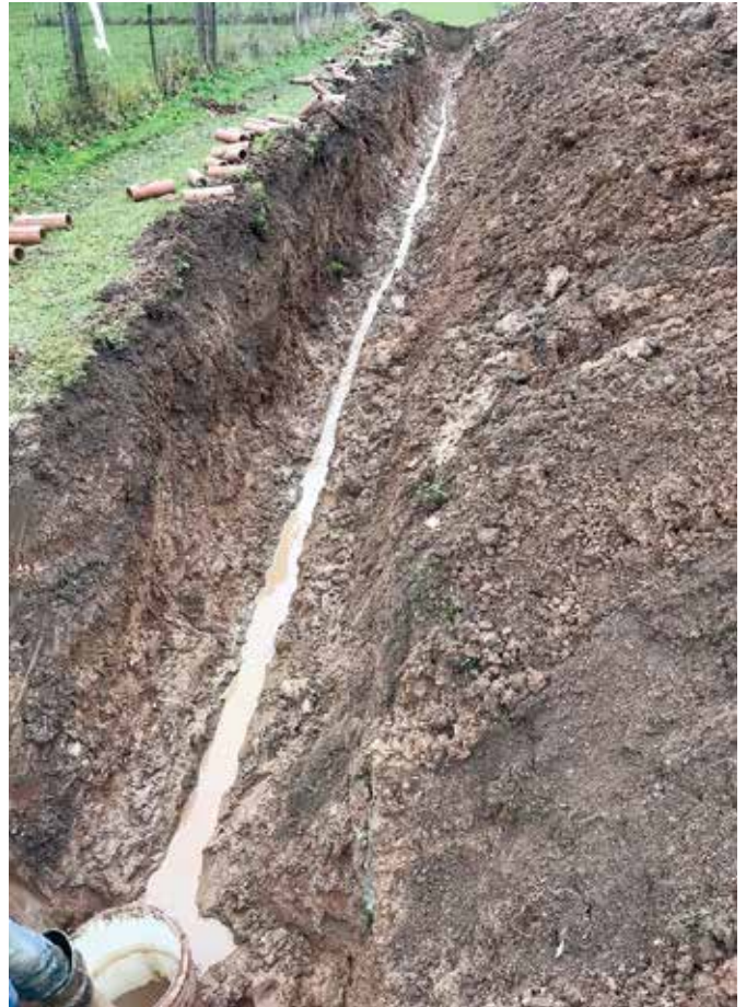
Drenāžas remonta darbi Bikstu pagastā.
