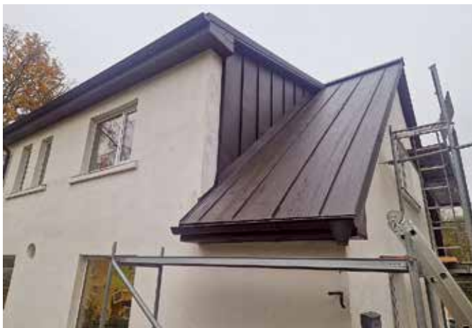
Bikstu pamatskolas palīgēkas jumta seguma nomaiņas darbi.
