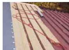
Jumta seguma PVC membrānas montāža uz ieklātām 2 kārtām akmens vates.
