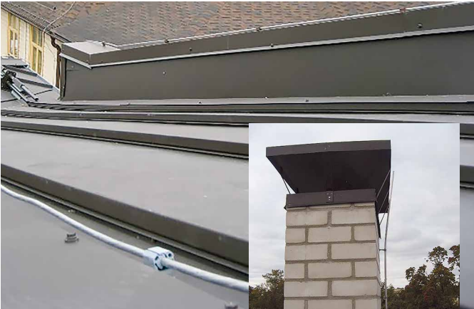
Sociālo pakalpojumu centra ēkas jumta seguma nomaiņas būvdarbu gaita Brīvības ielā 11, Dobeļē.
