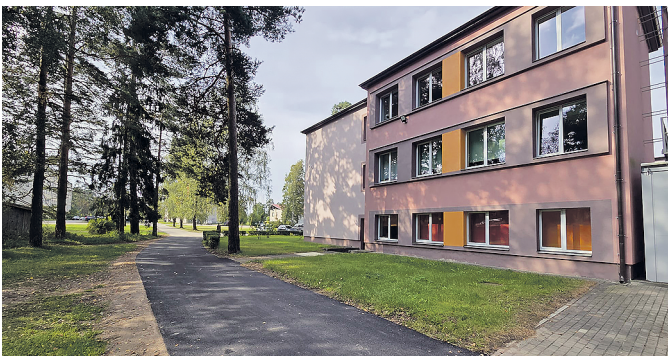
Atjaunotais asfaltbetona segums Priežu ielā 21, Gardenē.
