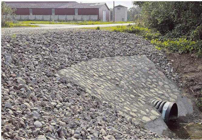
Caurtekas atbalstsienas izbūve Miltiņu ciematā, Bērzes pagastā, uz autoceļa "P97-Vērpīši".
