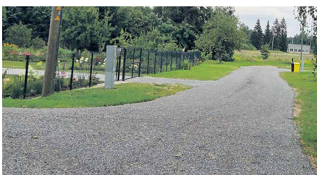
Divkārtu virsmas apstrāde Līduma ielā, Bēnē, Bēnes pagastā.
