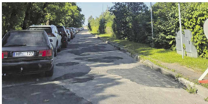
Asfaltbetona seguma bedrīšu remonts Ādama ielā, Dobelē.
