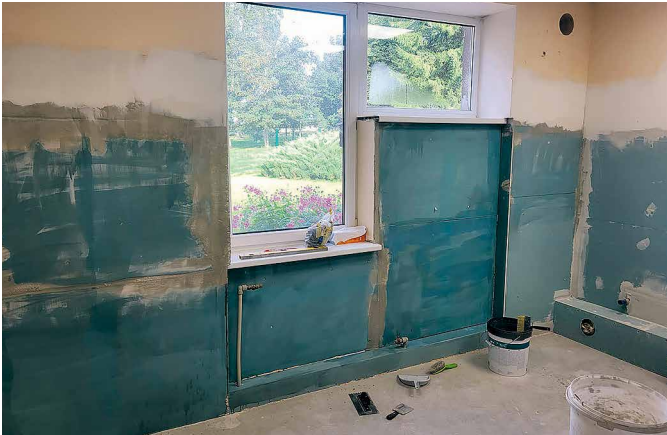
PII “Vecauce” WC telpu remontdarbu gaita.
