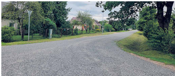
Vienkārtu virsmas apstrāde Puškina ielā, Aucē.
