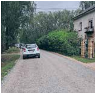
Divkārtu virsmas apstrāde Bēzres ielā, Dobelē.
