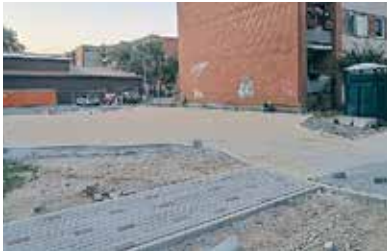
Auto stāvlaukuma izbūve Zaļajā ielā 21A, Dobelē.
