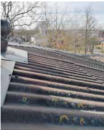
Esošais jumta segums Brīvības ielā 11, Dobelē.
