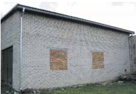
Saimniecības ēka “Katlu māja 2” Zebrēnes pagastā pēc jumta seguma un elementu maiņas.
