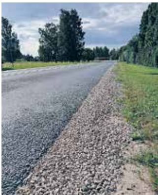
Ielas nomales iesēdumu un bedru remontdarbi Lauku ielā, Dobeļē.
