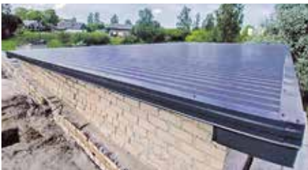
Saimniecības ēkai “Katlu māja 2” Zebrēnes pagastā jauniekļāts jumta segums.
