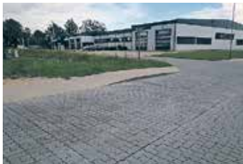
Ielas brauktuves bruģakmens iesēdumu labošana Katoļu ielā, Dobeļē.
