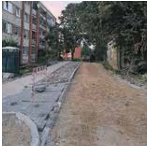
Jaunās ielas pārbūve Dobelē.
