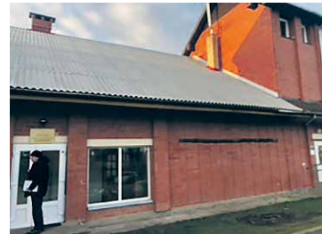
Izbūvētais “ETERNIT” segums virs galvenās ieejas.
