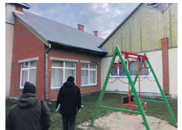
Sakārtota lietūs ūdens novadsistēma un vēdēļi “ETERNIT” seguma zonā.
