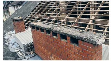
Vecā jumta seguma demontāža, latojuma līmeņošana.
