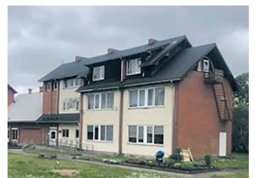
Izbūvēts ruļļmateriāla jumta segums.
