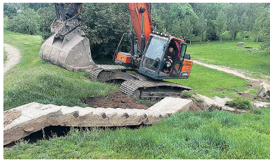
Kāpņu demontāžas process.
