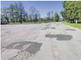
Asfaltbetona seguma bedrīšu remonts Lejasstrazdos, Dobeles pagastā.
