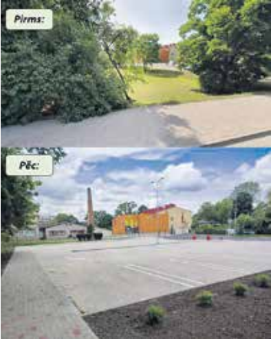
Jaunizbūvētais stāvlaukums Zaļajā ielā 22, Dobeļē, pie PII “Spodritis”.
