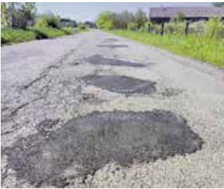
Asfaltbetona seguma bedrīšu remonts Vecauces pagastā.
