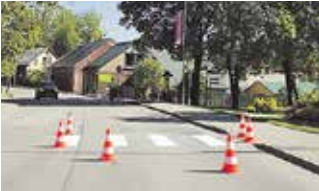
Ceļu horizontālo apzīmējumu krāsošana Aucē.
