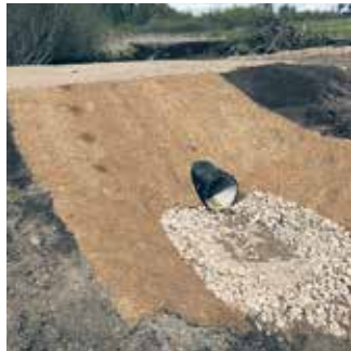
Izbūvētā caurteka grāvju ūdens novadīšanai Dobeles pagastā.
