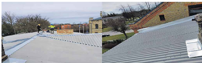
Ēkas Raiņa ielā 2, Aucē, jumta segums pēc veiktajiem remonta darbiem.
