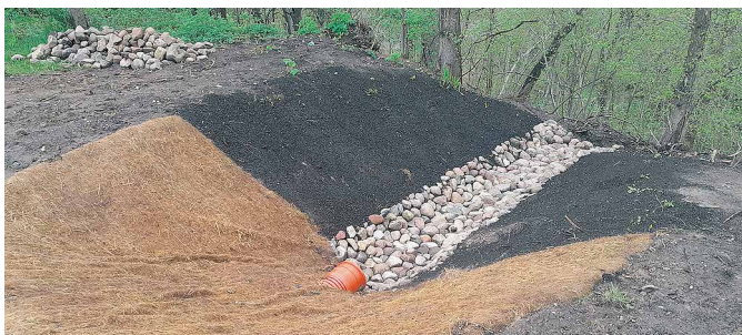
Kolektora iztekas grāvja gultnes un nogāžu nostiprināšana ar akmens krāvumu un ģeotekstilu.
