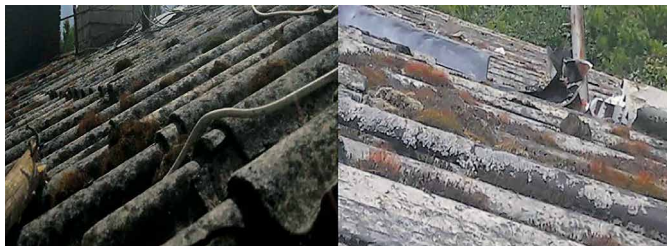
Jumta segums pirms remonta darbiem Raiņa ielā 2, Aucē.
