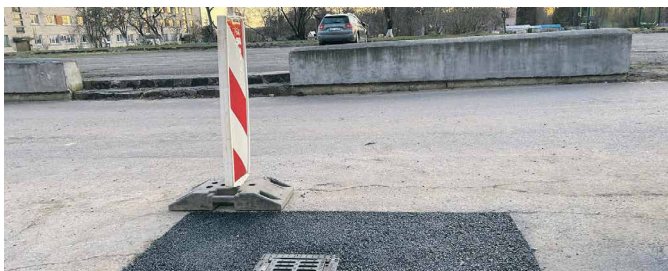
Gūlija un atjaunotais asfaltbetona seguma posms.
