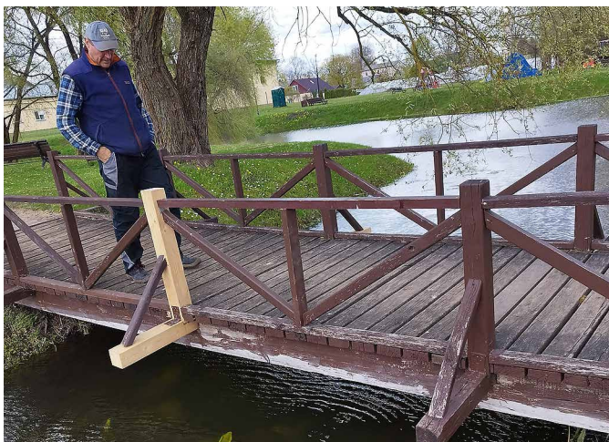
Gājēju tiltiņa/laipas remonts Aucē.
