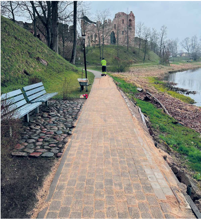
Dobeles pilsdrupu promenādes gājēju celiņš pēc bruģakmens pārlikšanas darbiem.
