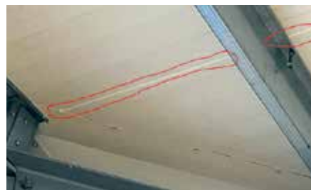
Tērvetes sporta halles jumta paneļu šuvju aizpildījums ar montāžas putām.
