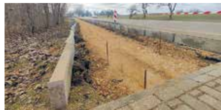
Gājēju celiņa būvdarbi Jelgavas ielā, Aucē
