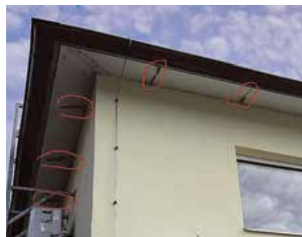
Tērvetes sporta halles jumta paneļu šuvju aizpildījums ar montāžas putām.
